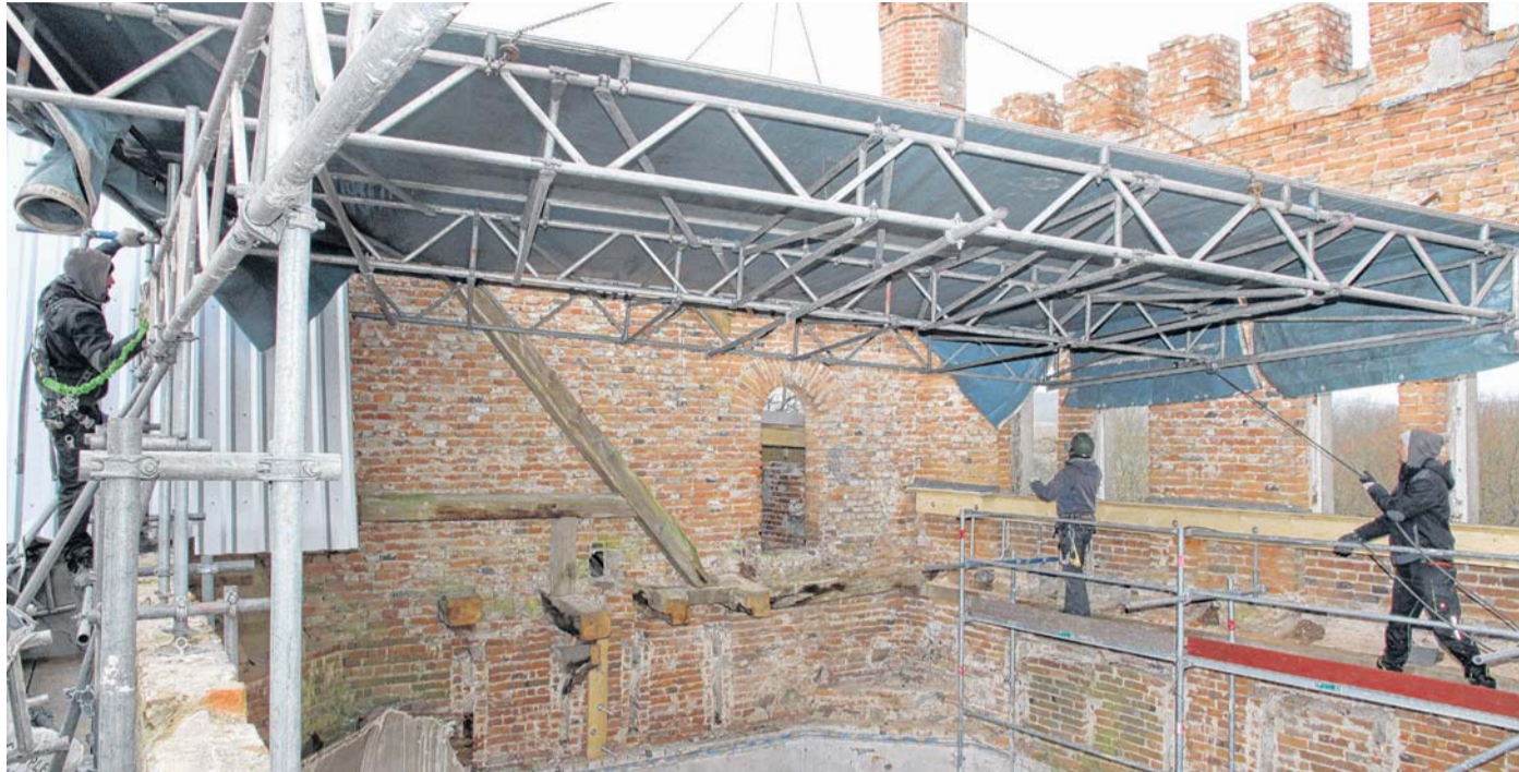
Zu Wochenbeginn kamen die letzten beiden Segmente für das Notdach der Broocker Schloss-Ruine an ihren Platz. Im Mittelrisalit entschieden sich die Planer für eine Leichtbau-Konstruktion, weil es dort nicht mal mehr Reste des alten Dachstuhls gibt. FOTO: STEFAN HOEFT
